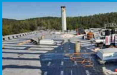
Thalheim, Stadtbadstraße 27 - 29 und 30 - 32: Erneuerung der Dacheindeckung
