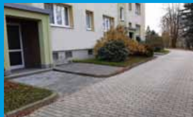
Stollberg , Hufelandstraße 10 - 16: Sanierung der Gebäudezufahrt
