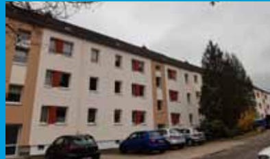
Thalheim , Tannenstraße 31 - 35: Komplexe Modernisierung und Anbau von Balkonen
