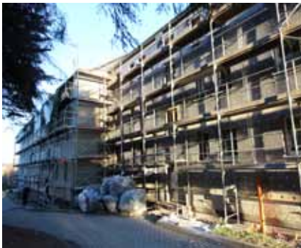
Thalheim, Tannenstraße 26–30: In Kürze wird das Wärmedämmverbundsystem verputzt sein und die Gerüste können weichen.
