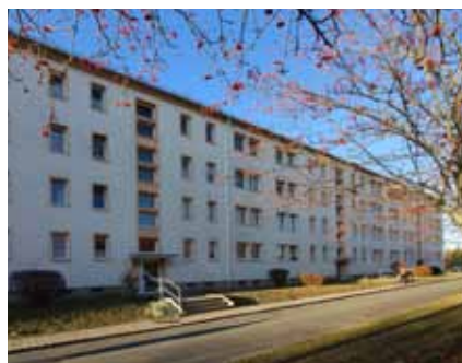
In unseren Häusern in der Bertolt-Brecht-Straße 5–7 und 8–10 wurden die Kellerfußböden erneuert.
