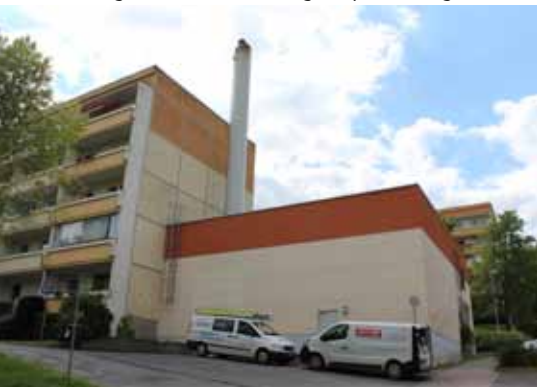
Unser Heizwerk in Thalheim wird mit Holzpellets befeuert. Nun ist es mit dem Biogas-BHKW der WBG „Zwönitztal“ verbunden.
