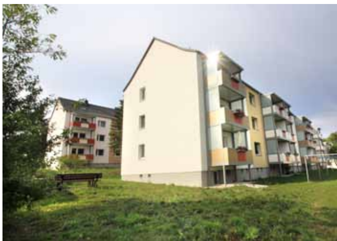
Bereits drei Wohnblöcke in der Tannenstraße in Thalheim wurden aufwendig umgebaut. Das Gebiet erhält dadurch eine spürbare Aufwertung.
