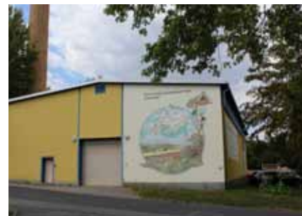
Die Wohnungsbaugesellschaft mbH „Zwönitztal“ betreibt ein Biogas-BHKW.
