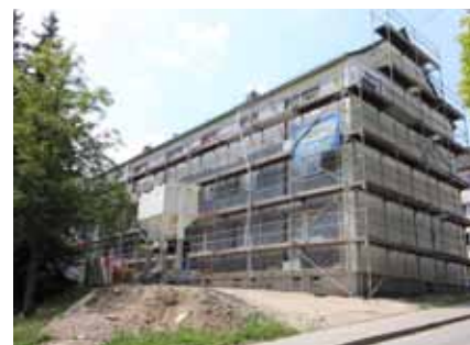
Die neue Wärmeverbundfassade ist bereits gut zu erkennen. Um die Belastungen so kurzzeitig wie möglich zu halten, wird an mehreren Stellen gleichzeitig gearbeitet.
