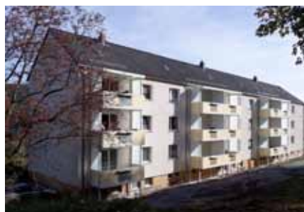
Neue Balkone in Auerbach
