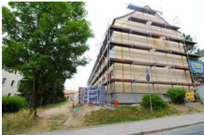
Die aktuellen Modernisierungsmaßnahmen an der Tannenstraße 19–21
