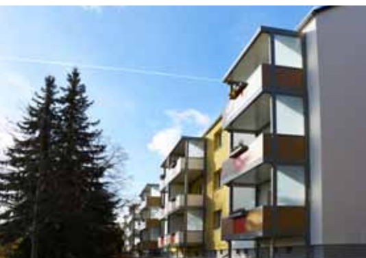
Der erste wichtige Meilenstein für das große Vorhaben im Wohngebiet Tannenstraße. Die Modernisierung für die Tannenstraße 12–15 ist abgeschlossen.
