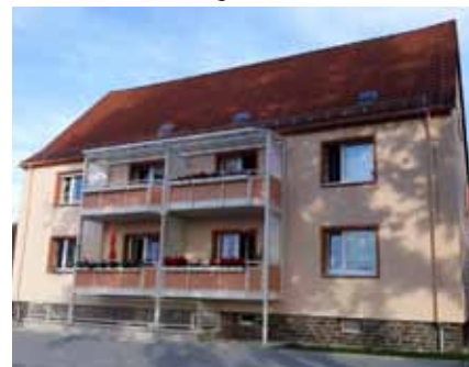
Nach der Modernisierung der Glückaufstraße 19
