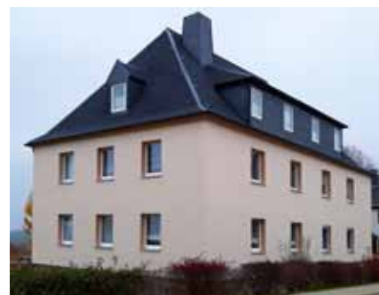
Ein schönes neues Dach für die A.-Kempe-Str. 46
